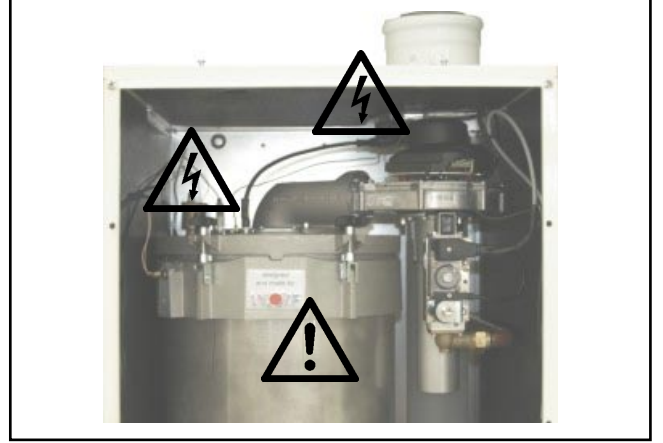
Resim: Ateşleme trafosu, yüksek gerilimli ateşleme elektrodu ve ısı eşanjöründe elektrik gerilimi vardır. Aşırı ısınmış parçalarda yanma tehlikesi vardır.
