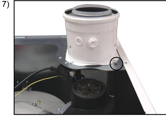
7) Cihazın üst kapağının çıkartılmasından sonra baca vidalarını çözün.
