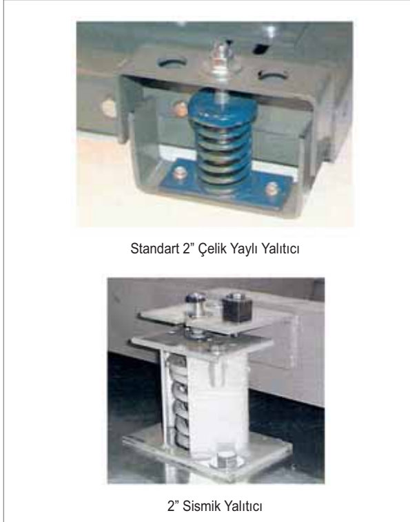
Şekil 49. Fan yaylı titreşim yalıtıcıları
